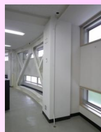
→ 館内にパイプを通します
