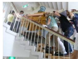
階段の高さに合わせて一段一段足場を組んでの作業
