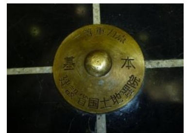
「1等重力点」と刻字された直径約8cmの金属標
