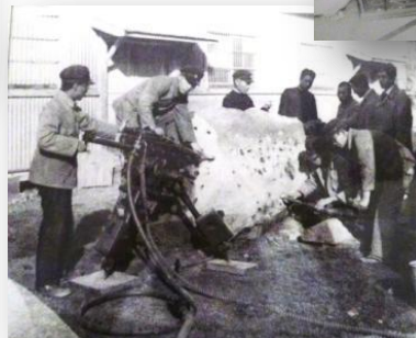
削岩実習の様子。学生たちはドリルで火薬の埋込み穴を開けている
