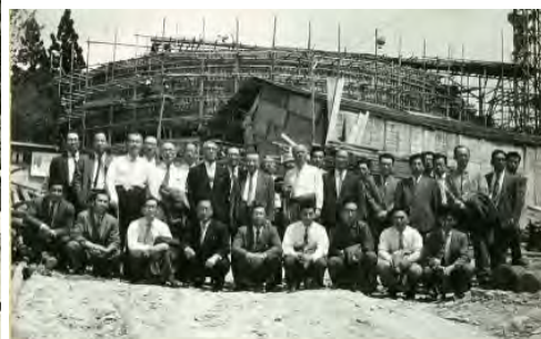
建設中の博物館と建設に携わった方々
