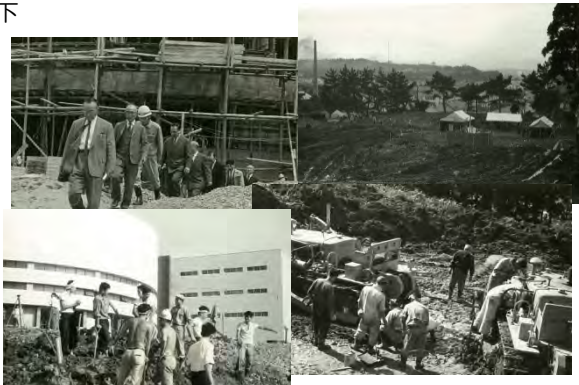
建設前の観音台(現在の博物館の場所)と建設中の様子
